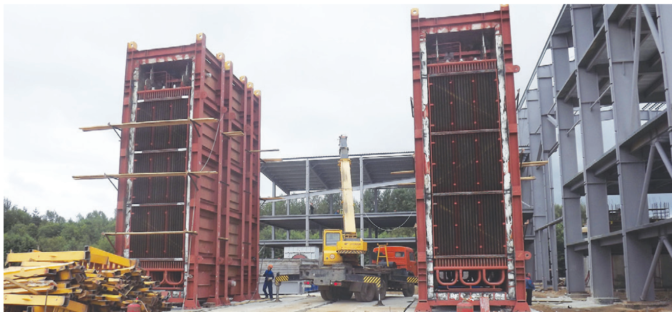
СТРОИТЕЛЬСТВО ПГУ-ТЭС-52 В ГОРОДЕ ТУТАЕВЕ.
