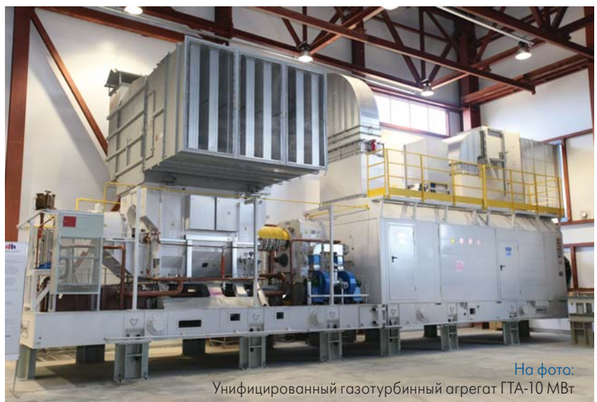
На фото: Унифицированный газотурбинный агрегат ГТА-16 МВт
