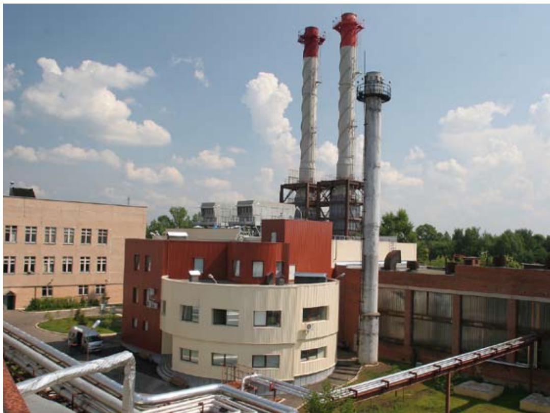
Газотурбинная электростанция ГТЭС-12 Мвт производства ОАО «ОДК-Газовые турбины»
